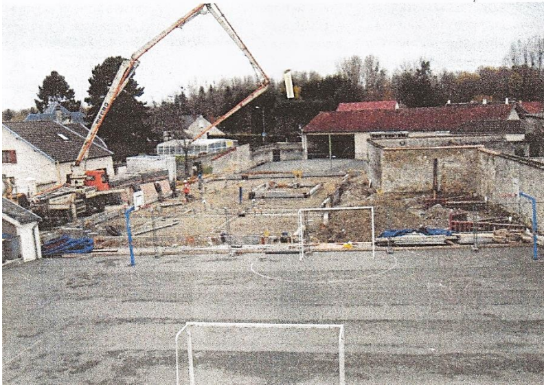
Début des travaux
